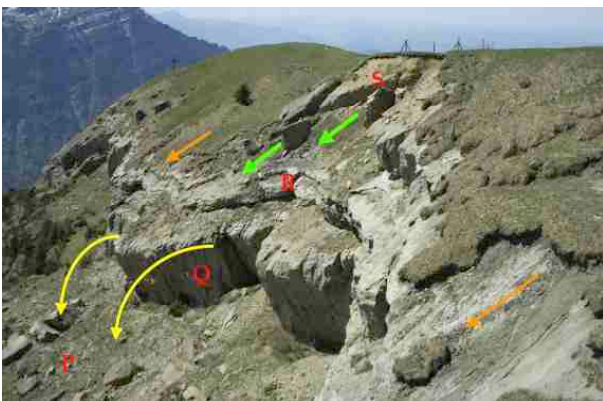
Fig. 15: Darstellung aller risikorelevanten Prozesse im Gratbereich. Gelber Pfeil: Toppling, starke Intensität. Grüner Pfeil: Kriechen, Gleiten und Stürzen von Festgestein und einzelnen Blöcken, mittlere Intensität. Oranger Pfeil: Langsames Abgleiten von Lockermaterial auf Mergelschicht, schwache bis mittlere Intensität. Im rechten unteren Bildrand in fortgeschrittenem Stadium. (Gipfelkreuz = Gnippen).
